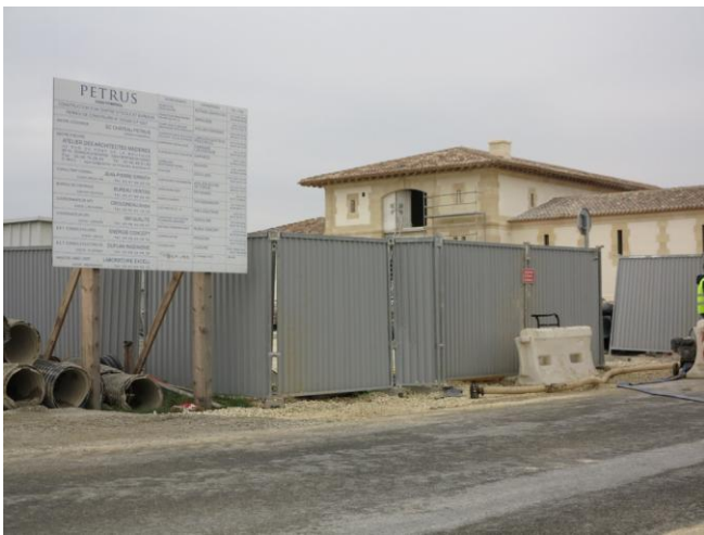
正在建築中的柏翠新酒窖，預計 2013 完工
